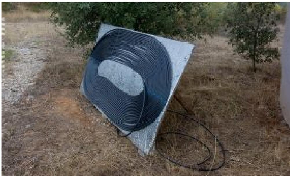
El panel solar de bricolaje, solamente 2 metros separado del sistema interior de tubería y expuesto al sur. Mide unos 2 por 1 metro y sujeta 100 metros de tubo negro. 18 de septiembre 2017.
