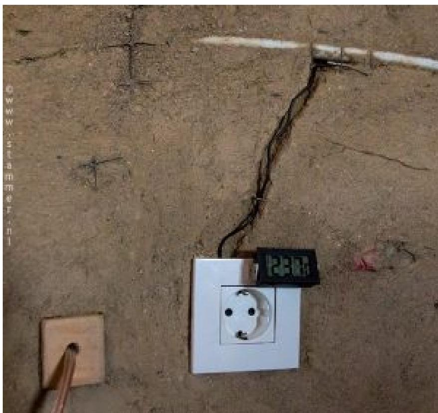
Este termómetro digital, fijado en un enchufe, está conectado con el sensor cerca del tubo de calefacción. Después de pintar la pared con cal, es el único elemento visible del sistema en el interior. Registra la temperatura cerca del punto de entrada donde el agua es la más caliente. En un típico día de invierno suele establecerse alrededor de 28°C. 30 de octubre, 2017.
