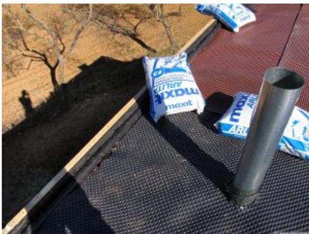
La lámina drenante de HDPE (en dos colores) está extendida y puede ser cubierta por el geotextil. El tubo negro de PE tiene muchos agujeros y recoge el agua de lluvia que baja por el tejado. La chimenea necesita parches especiales auto-adhesivos de EPDM para sellar. Los bolsos de plástico contienen los gránulos de arcilla expandida ('Arlita').
