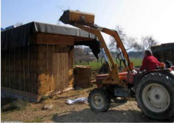
Marzo 2009. La lona de EPDM de una sola pieza es tremendamente pesada y se subió, igual que la tierra, con esta pala.
