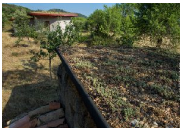
Junio 2018. El tejado Sedum sobre la caseta del aseo de compost. Al fondo la
