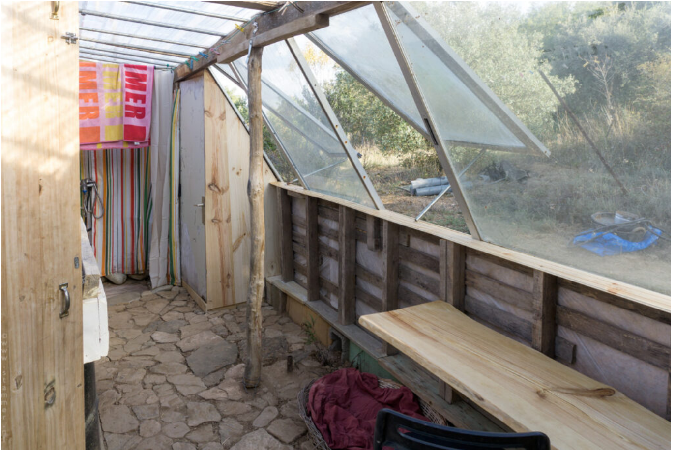
Interior del invernadero nuevo, construido con palets, tela blanca de geotextil, malla metálica y adobe.
