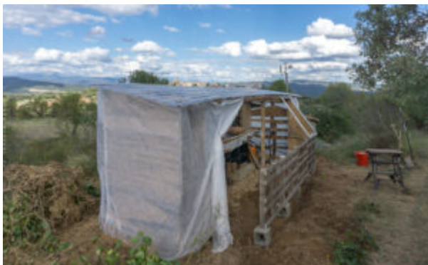
La tela de geo-textil se fija con grapas.
