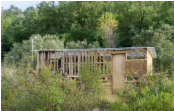
Los palets atornillados en su sitio, con el tejado de policarbonato (2 láminas de 1x6m) instalado.
